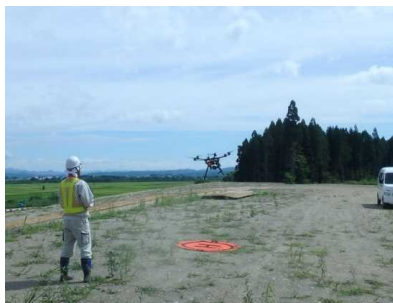
UAVによる起工測量状況
